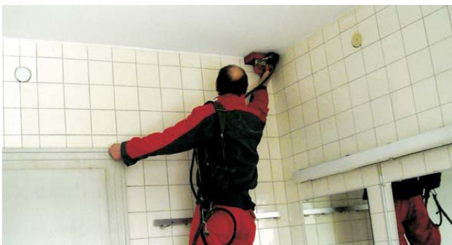
F Messung an der Deckenunterseite
